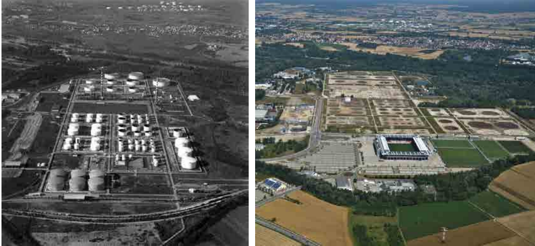
Abb. 1. Luftbilder 1970/2013, Blick von Süden auf Bayernoil-Gelände - Quelle: Pöhler
