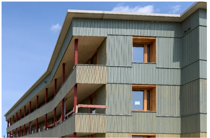
Neubau Steigerwaldstraße – Haus fast ohne Heizung
