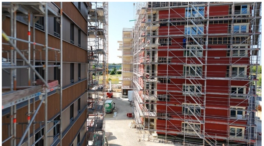
Baustelle an der Hans-Struck-Straße
