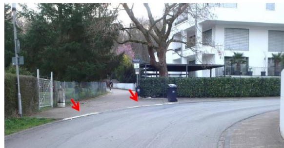
Abbildung 21 Markierung abgesenkter Bordstein (Quelle: Stadt Darmstadt)
