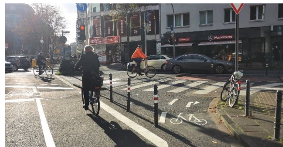
Abbildung 24 Rückgebauter freilaufender RA (Quelle: Stadt Köln)
