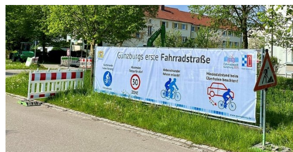
Abbildung 14 Baustellenbanner Fahrradstraße (Quelle: Stadt Günzburg)
