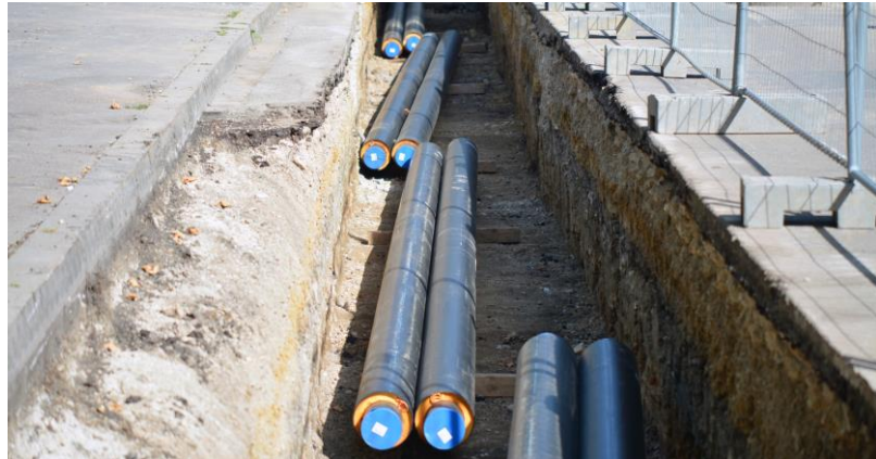
Fernwärmeausbau in Ingolstadt durch die Stadtwerke Ingolstadt ©Stadt Ingolstadt
