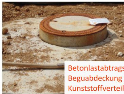
Abbildung 9: Beispiele von Kunststoff-Verteilerschächten für Erdwärmesondenanlagen (Quelle: tewag GmbH)
