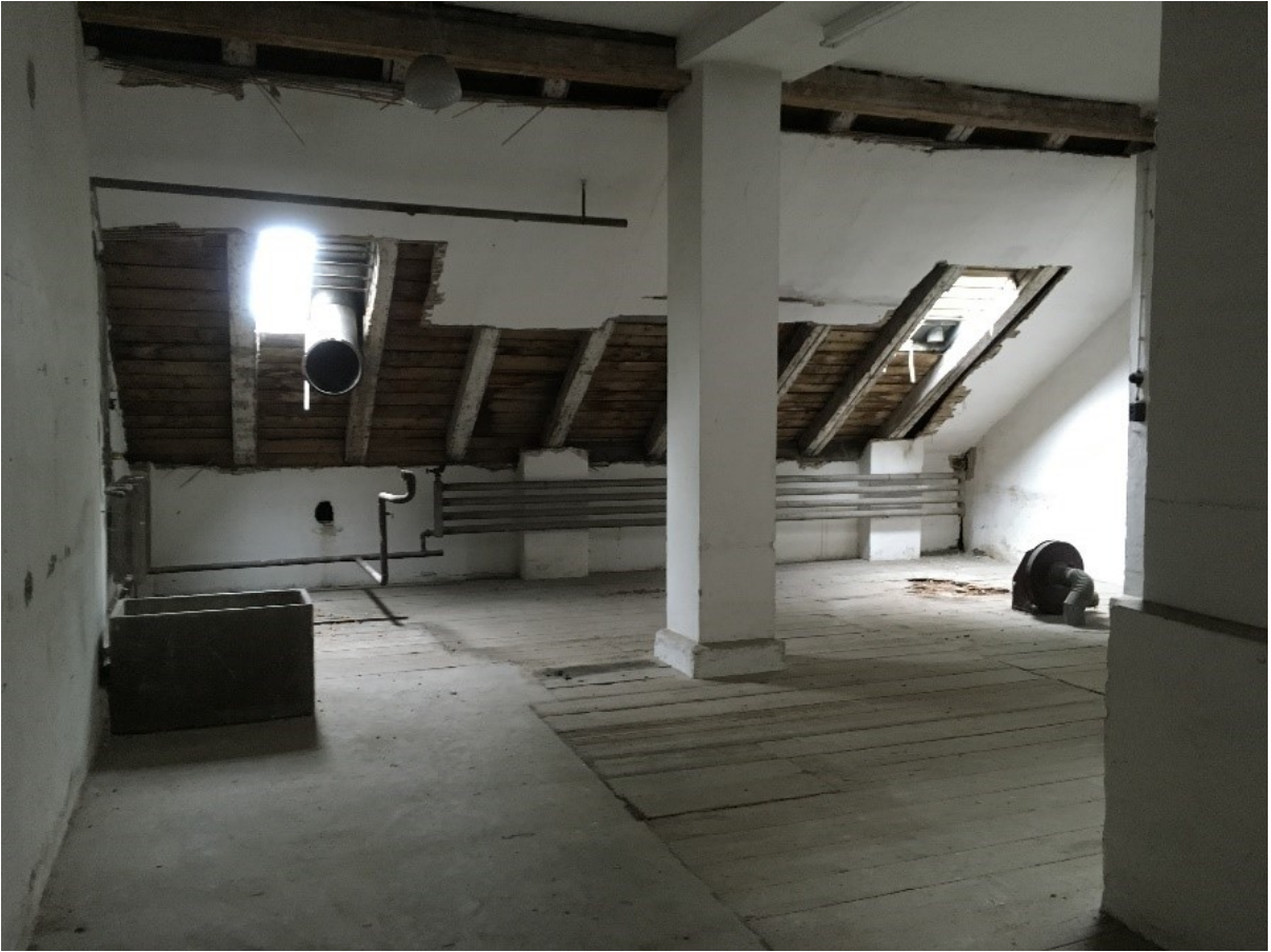
Abb. 7 Dachraum der Westlichen Seite
