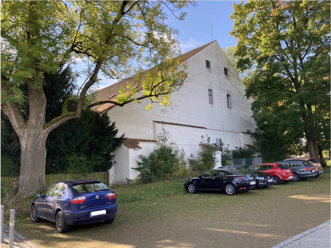
Abb. 5 Ansicht von Norden
