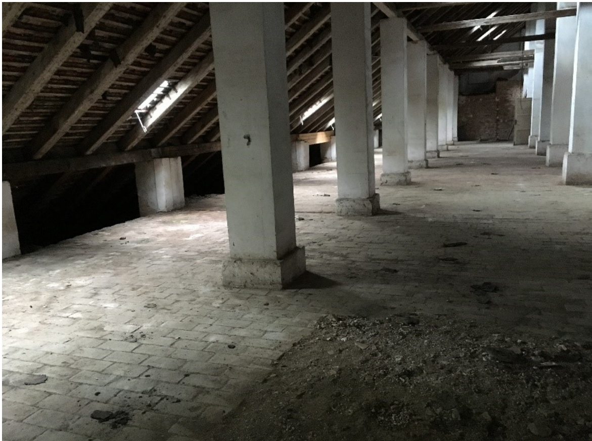
Abb. 6 Dachraum der Östlichen Seite
