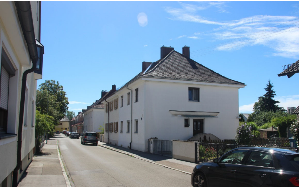
Abbildung 8: Körnerstraße 1 und 3, Blick nach Süden
