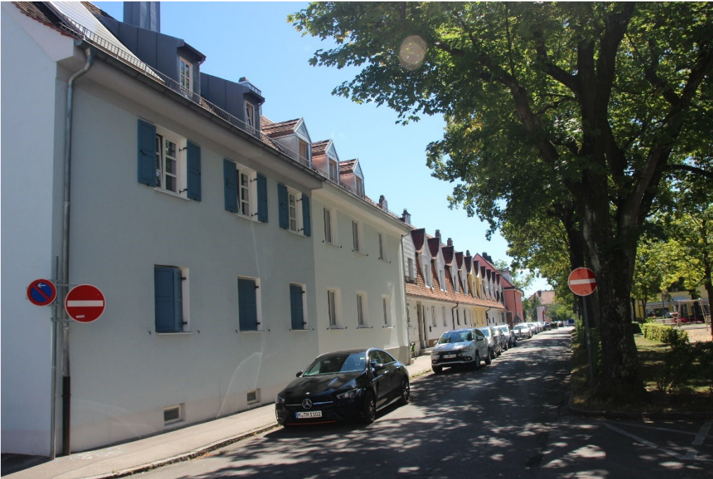
Abbildung 1: Körnerstraße 10, 12 - Blick nach Süden
