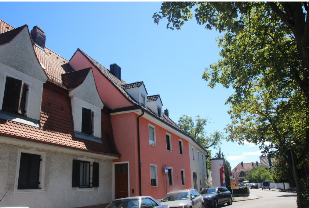
Abbildung 4: Kopfbauten 26, 28, Blick nach Süden
