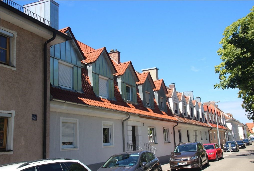
Abbildung 7: Körnerstraße 13 - 5, Blick nach Norden
