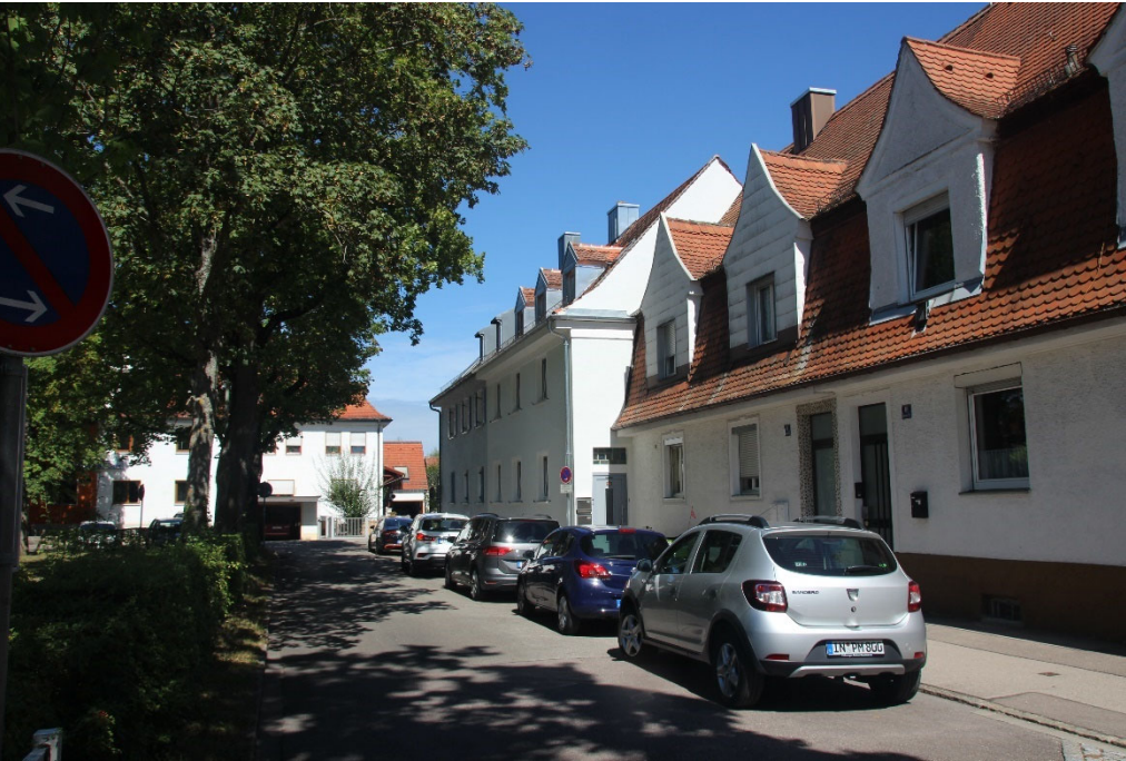
Abbildung 3: Körnerstraße 14, 12, 10, Blick nach Norden
