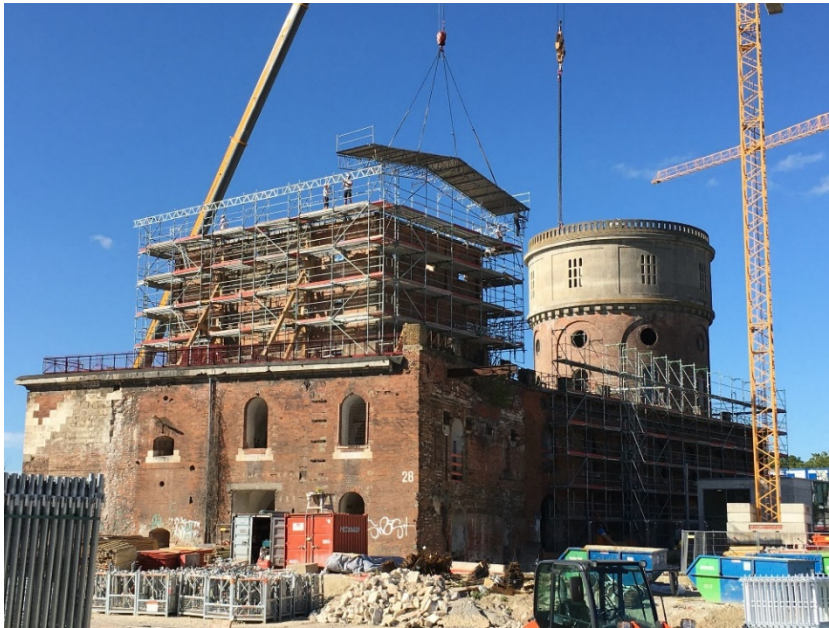
Kavalier Dalwigk - Bau provisorisches Dach Trafohaus
