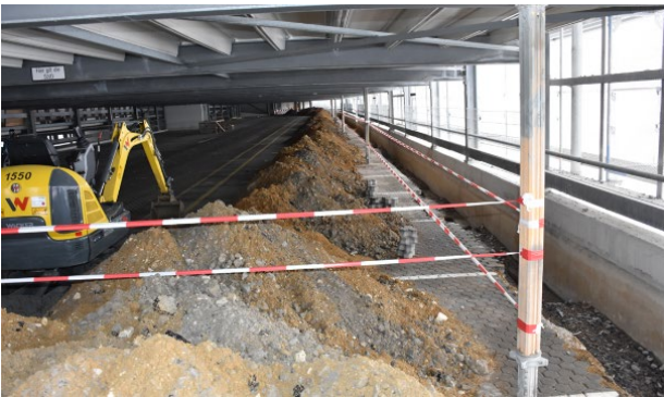
Sanierung Parkhaus Hauptbahnhof West
