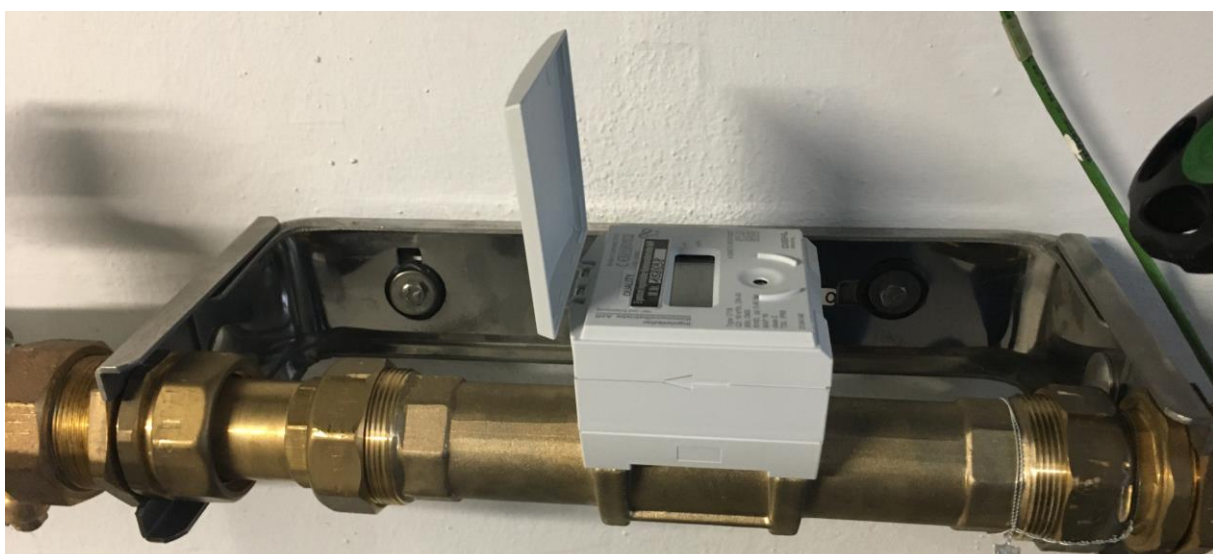
Beispiel eines Smart Meter: Wasserzähler im Christoph-Scheiner-Gymnasium
