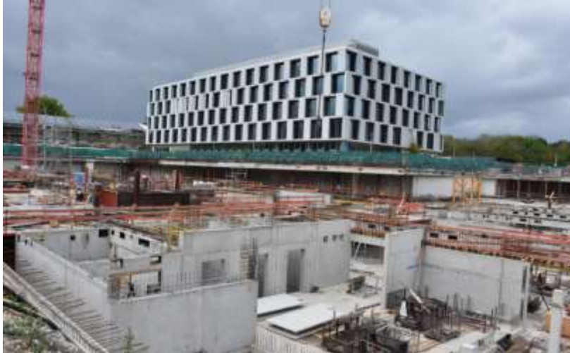
2. Untergeschoss mit Zwischenwänden
