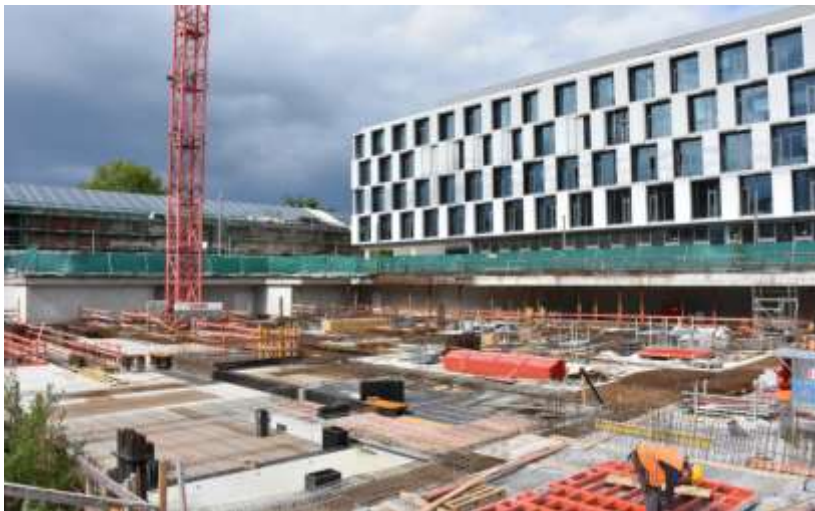
1. Untergeschoss (Bodenplatte CC-IN & Hotel)
