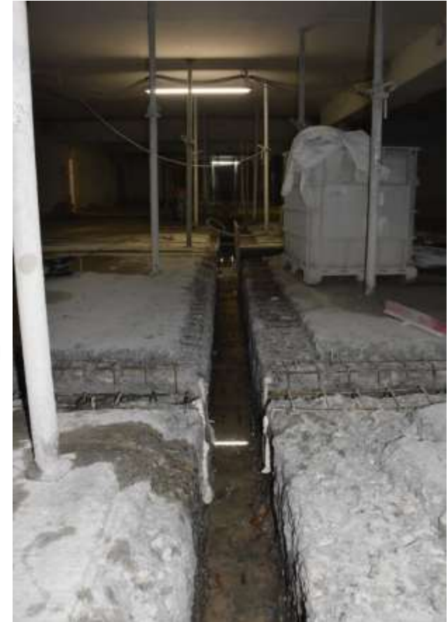
2. Untergeschoss Profilierung der neuen Rinne
