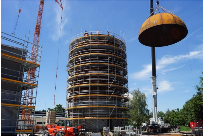
Bau eines Wärmespeichers an der Ringlerstraße
