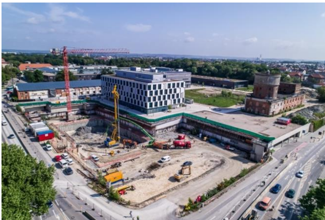
Baufortschritt am Gießereigelände
