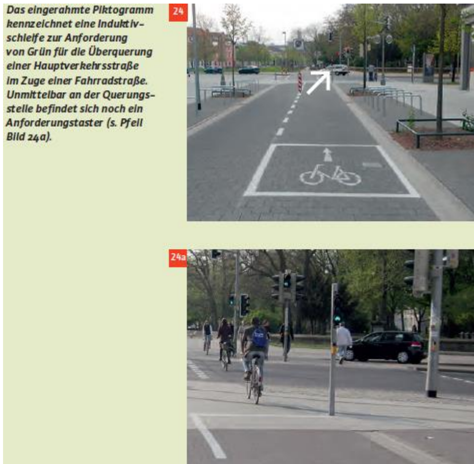
Abbildung 5 Bedarfsanforderung für Radverkehr mittels Induktionsschleife und Drücker (Quelle: Stadt Münster (2013), Signale für den Radverkehr)
