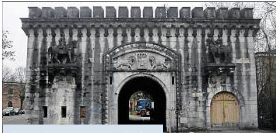
Vor der Sanierung war das Tor vor dem Kavalier Hepp von einem schwarzen Belag überzogen, jetzt erstrahlt es wieder in frischem Weiß. Fotos: Harst
