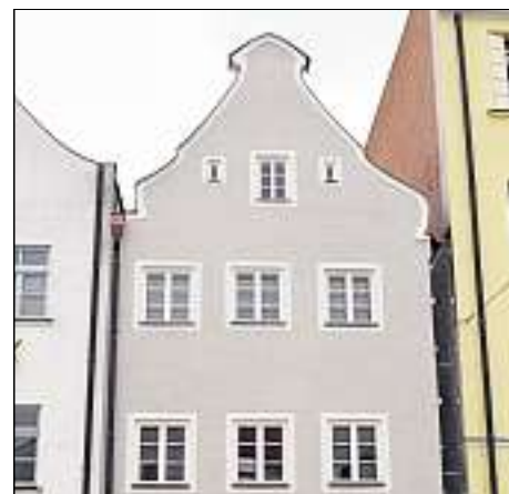
Das ehemalige Handwerkerhaus in der Theresienstraße wurde aufwendig saniert. Foto: Betz
