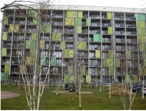
Sanierung Wohngebäude und Wohnumfeldgestaltung Dörflerstraße (GWG)
