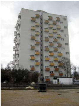
Sanierung Wohngebäude Goethestraße (WEG)
