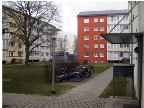
Sanierung Wohngebäude und Wohnumfeldgestaltung Haenlinstraße (St. Gundekar Werk GmbH)
