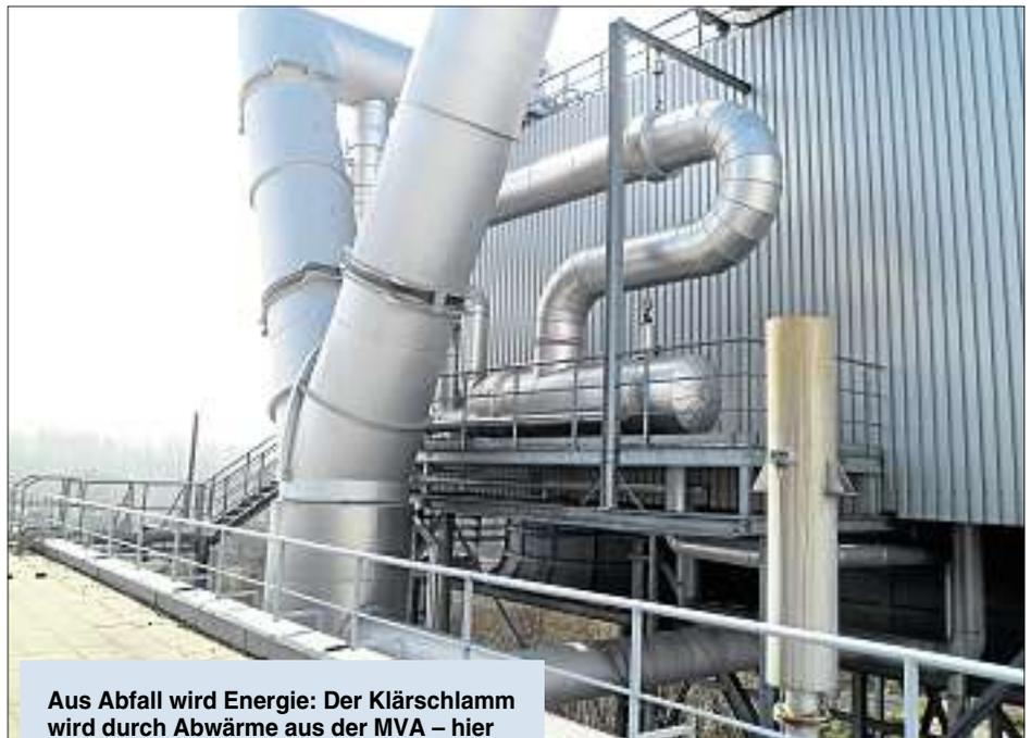
**Aus Abfall wird Energie:** Der Klärschlamm wird durch Abwärme aus der MVA – hier der Wärmetauscher (Bild oben) – in der Trocknungsanlage zu einem Granulat mit hohem Brennwert. Fotos: ZKA
