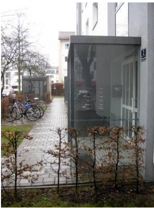
Sanierung Wohngebäude und Wohnumfeldgestaltung Südliche Ringstraße, Manchinger Straße (GWG)
