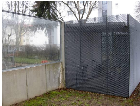
Errichtung Lärmschutz und Nebengebäude Südliche Ringstraße, Manchinger Straße (GWG)
