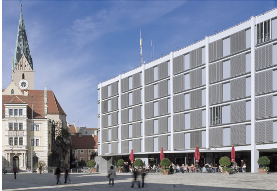
Fassade Neues Rathaus: Bestand
