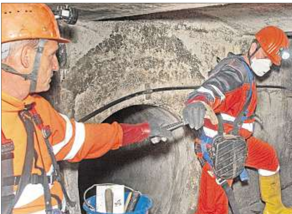
Der Untergrund von Ingolstadt: Die Ingolstädter Kanäle werden zur Sicherstellung einer funktionierenden Entwässerung regelmäßig kontrolliert.
