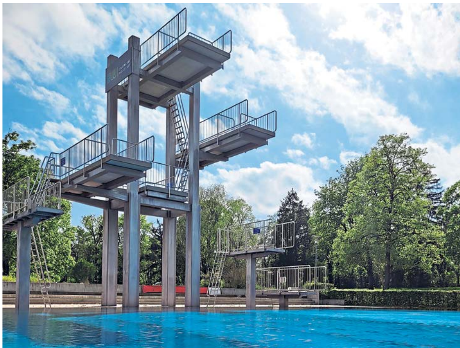
Pünktlich zur neuen Saison wurden die Sprungbretter des Sprungturmes erneuert.
