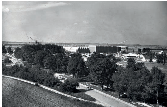
Werksgelände der Auto Union an der Ettinger Straße (Stadtarchiv Ingolstadt)
