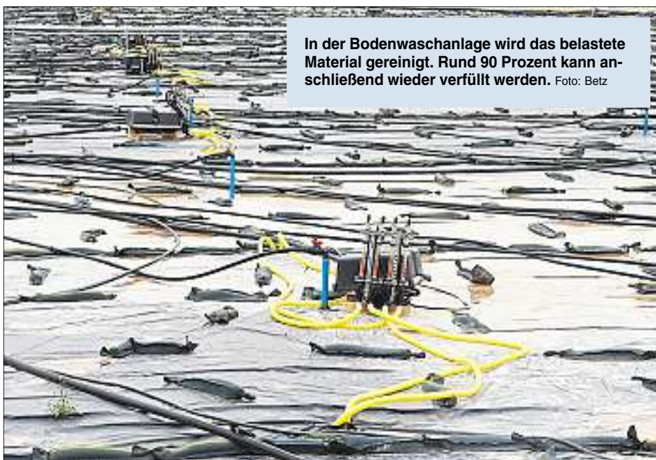
Beim „Air Sparging“-Verfahren wird Luft in den Boden gepumpt, um so Schadstoffe aus dem Grundwasser zu bekommen. Foto: Betz
