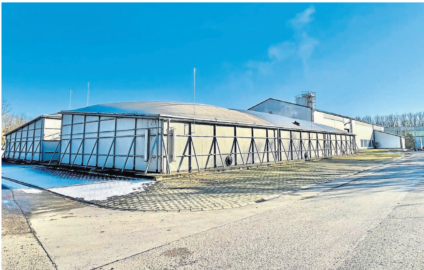
Umweltfreundliche Abluftreinigung: Die Biofilteranlage der ZKA
