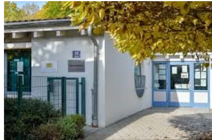
Foto: Kita am Nordpark
