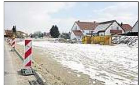
Die auffällige Brücke über das ehemalige Eriag-Gleis in Niederfeld ist nicht mehr notwendig und wurde daher inklusive der Rampen zurückgebaut. Noch bis Herbst wird nun die Rothenturmer Straße auf Höhe der bestehenden Bebauung ausgebaut (sechs Meter breite Fahrbahn, zwei Meter Park- und Grünstreifen und beidseitige Gehwege). Ebenfalls erneuert werden die Straßenbeleuchtung und beide Bushaltestellen. Die Kosten betragen rund 850 000 Euro. Foto: Betz
