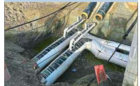
Foto 5: Umverlegung Fernwärme
