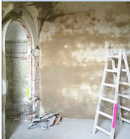
Foto 2: Putzarbeiten Foto: INKoBau
