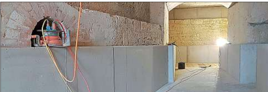
Foto 6: Verbindungsgang zwischen Kavalier Dalwigk und Neubau Foto: INKoBau
