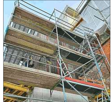
Foto 7: Rohbauarbeiten am Aufzugschacht Foto: Leitwerk AG
