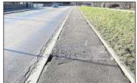
Der 1966 hergestellte Rad- und Gehweg an der Peisserstraße zeigt alterungsbedingte Schäden. Für die Radfahrer ist diese Situation eher unkomfortabel. Weil aufgrund des Gesamtzustandes mit kleinflächigen Reparaturen keine wesentliche und dauerhafte Verbesserung der Situation erzielt werden kann, werden die Geh- und Radwege erneuert. Außerdem wird eine Bushaltestelle barrierefrei umgebaut. Die Projektkosten betragen rund 510 000 Euro. Foto: Tiefbauamt
