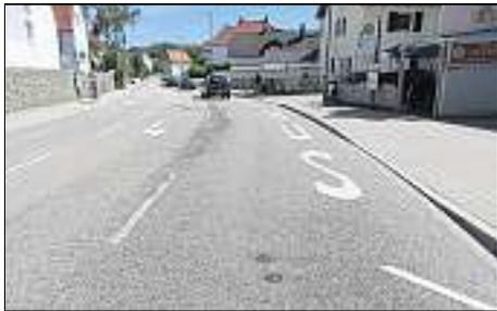
Die Hauwöhler Straße im Abschnitt von der Eigenheimstraße bis zur Hagauer Straße wurde 2010 mit einem lärmoptimierten Asphaltbelag ausgestattet. Nach starker Verkehrsbelastung zeigt sich insbesondere in den Einmündungsbereichen und Fahrspuren ein deutlicher Verschleiß und eine bausubstanzerhaltende Deckensanierung muss durchgeführt werden. Mitte Mai wird die Straße deshalb für wenige Tage voll gesperrt. Kosten: rund 300 000 Euro. Foto: Tiefbauamt
