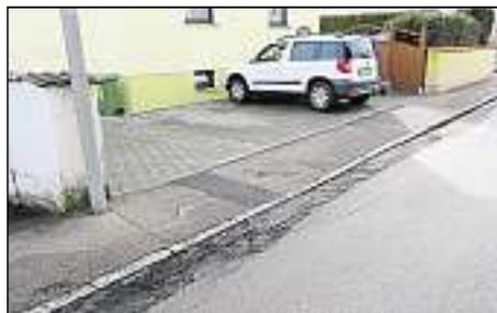
Die Sandtnerstraße weist Setzungen, Risse und Flickstellen auf. Neben der Erneuerung der Fahrbahn erhalten die Gehwege ein Betonsteinpflaster auf einer Schottertragschicht. Die Straßenbeleuchtung wird mit LED-Leuchten versehen. Die Fahrbahnsanierung erfolgt in zwei Bauabschnitten (Bodenehrstraße bis Sambergerstraße und dann weiter bis Am Konkordiaweiher) zwischen Juni und Oktober unter Vollsperrung des Verkehrs (Umleitungen werden eingerichtet). Foto: Tiefbauamt
