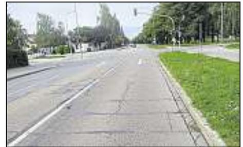
Die Maximilianstraße/Am Pulverl braucht substanzsichernde Sanierungsmaßnahmen, um Rissen, Flickstellen und Setzungen sowie Problemen mit der Straßenentwässerung entgegenzuwirken. Bohrkernuntersuchungen haben zudem ergeben, dass auch die darunterliegenden bituminösen Tragschichten beschädigt sind. Anfang bis Ende Juli werden die Bushaltestellen umgebaut, anschließend folgen Anfang August die neuen Asphaltdecken. Foto: Tiefbauamt
