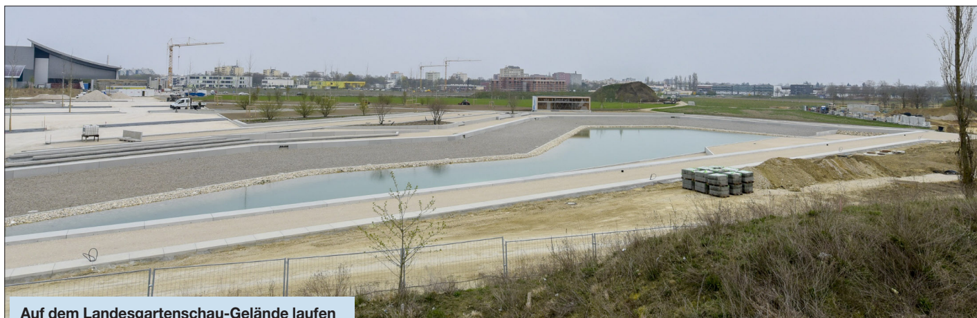
Auf dem Landesgartenschau-Gelände laufen die Bauarbeiten auf Hochtouren, die Eröffnung ist am 24. April 2020. Foto: Rössle
