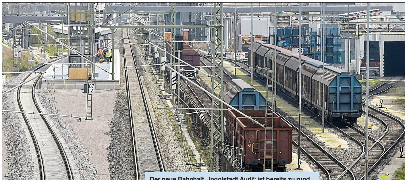
Der neue Bahnhalt „Ingolstadt Audi“ ist bereits zu rund 75 Prozent fertiggestellt. Im Dezember wird die Station pünktlich zum Fahrplanwechsel eröffnet. Foto: Rössle
