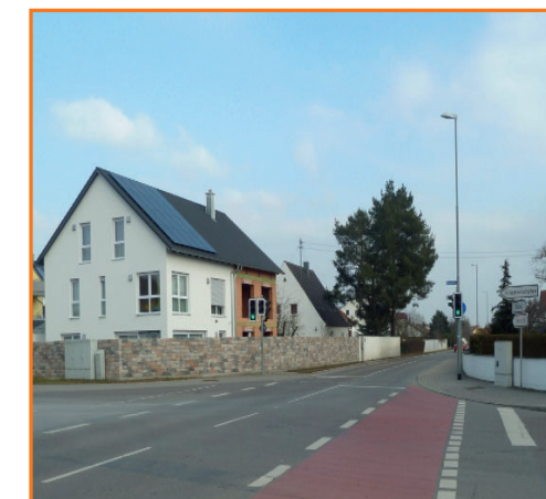
Fußgängerampel in der Wilhelm-Busch-Straße
