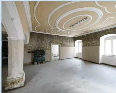
Sanierung INKoBau informiert über Kavalier Dalwigk und Georgianum
