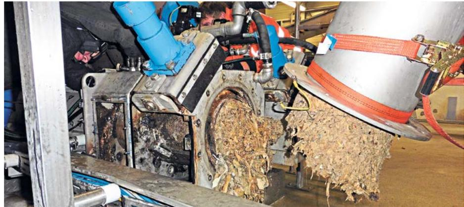
**Durch Fremdstoffe kommt es zu Störungen in der Anlage, wie bei dieser Verzapfung im Pressrohr der Waschpresse. Diese Störungen müssen mühsam entfernt werden.**
