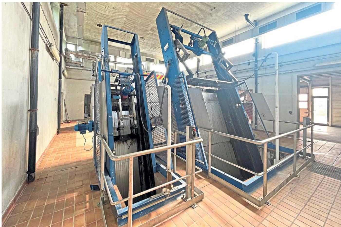
**Die allererste Stufe in der Kläranlage: Im Rechenhaus fließt das Abwasser erst durch einen Grobrechen und danach durch den Feinrechen.**
