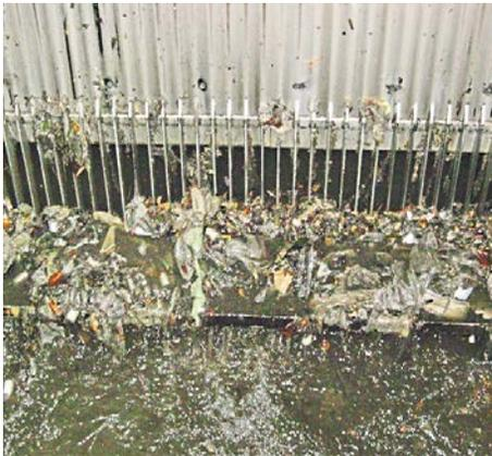
**An den Stäben des Grobrechens mit 40 Millimeter Abstand bleibt schon einiges hängen.**
