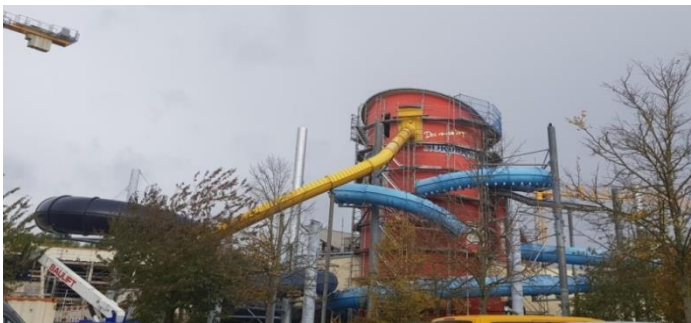
Baustelle Erlebnisbad Wonnemar
